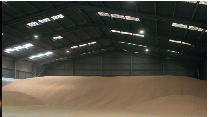
Forth Ports nach der LED-Installation
