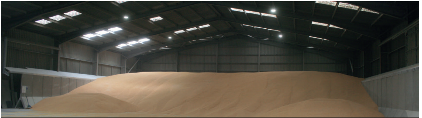
Installation neuer LED-Leuchten von Dialight bei Forth Ports
