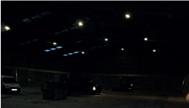
Forth Ports vor der LED-Installation
